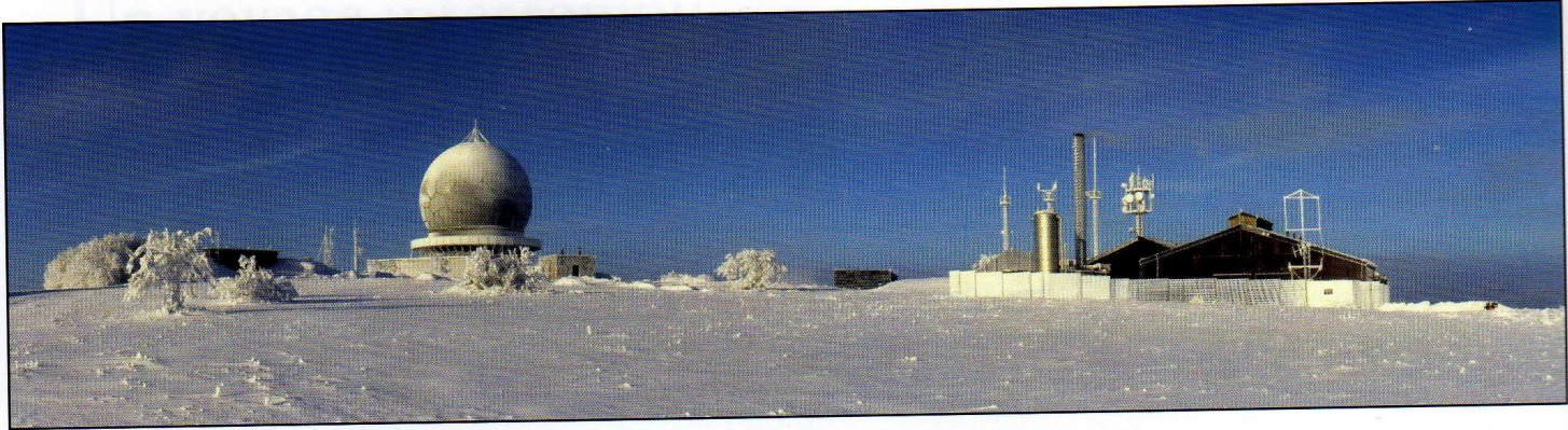
Radôme et centrale de cogénération en hiver. (crédit photo : wikipedia)
